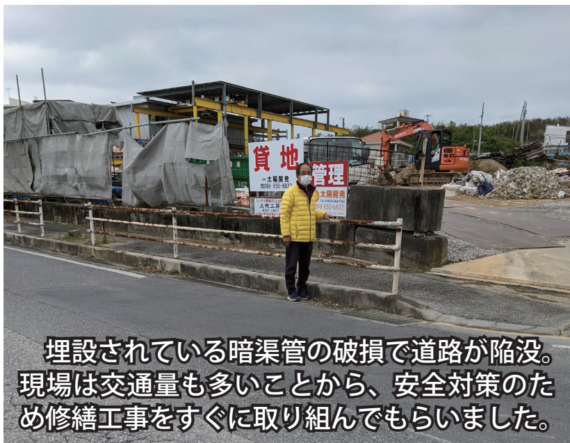
金良324-1立神鉄工所前の市道40号、道路陥没補修 (令和3年12月議会)
